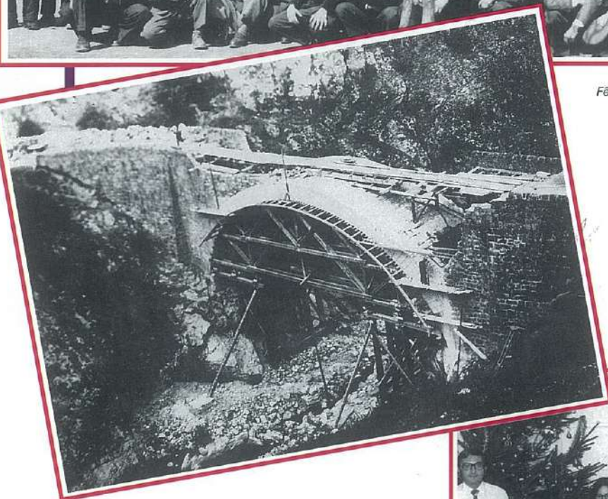
Reconstruction du pont du Rô détruit par la Résistance (septembre 1945).
