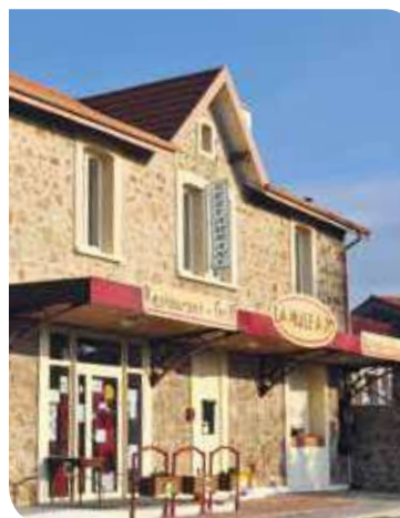
Rénovation du restaurant
