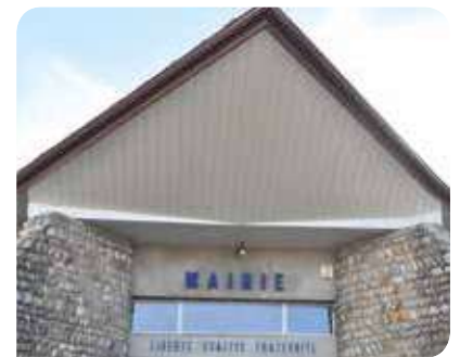
Réfection du toit de la mairie
